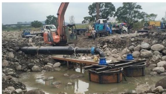
圖 14 油羅溪緊急抽水施工照片
