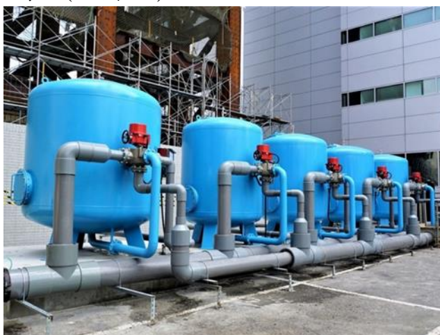
圖 19 建築工地地下水利用
