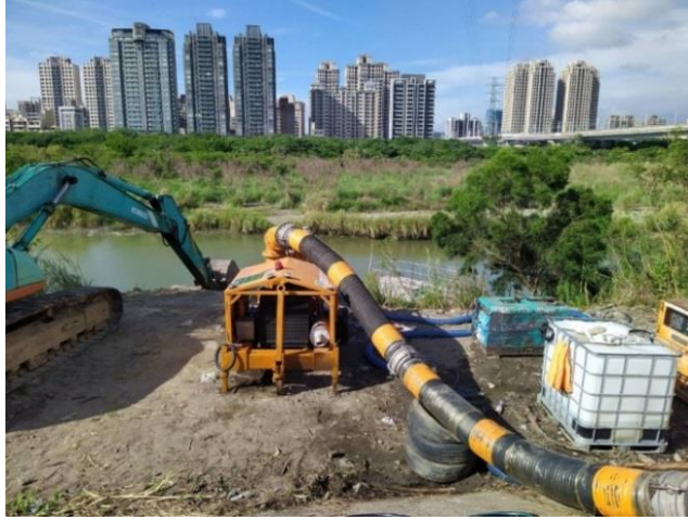
圖 15 隆恩堰下游緊急抽水情形
