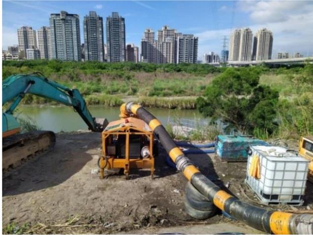
**圖 15 隆恩堰下游緊急抽水情形**
